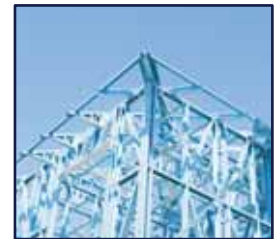
Stal - Konstrukcje Stalowe
